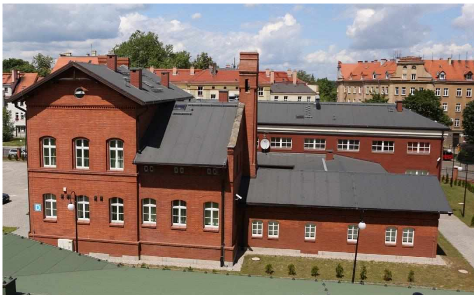
Rycina 11 Budynek D
