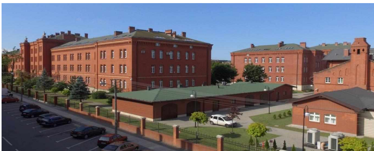
Rycina 7 Budynek A
