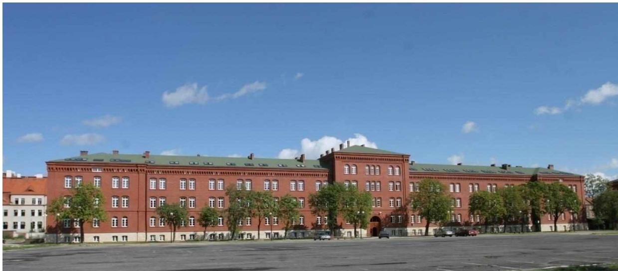
Rycina 8 Budynek C
