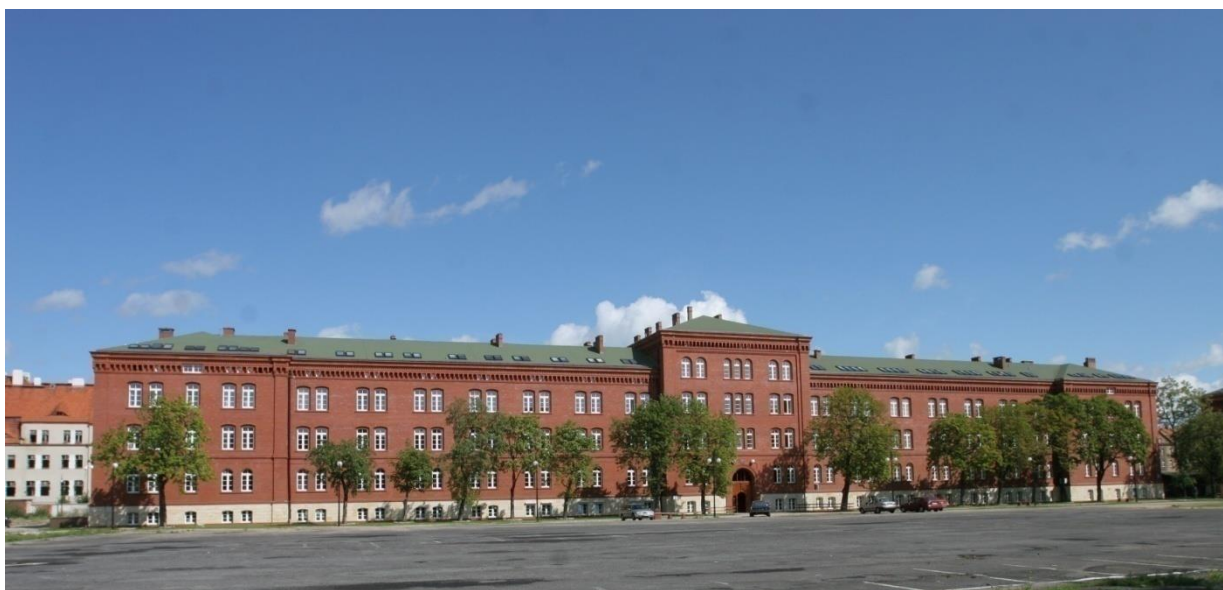
Rycina 8 Budynek C
