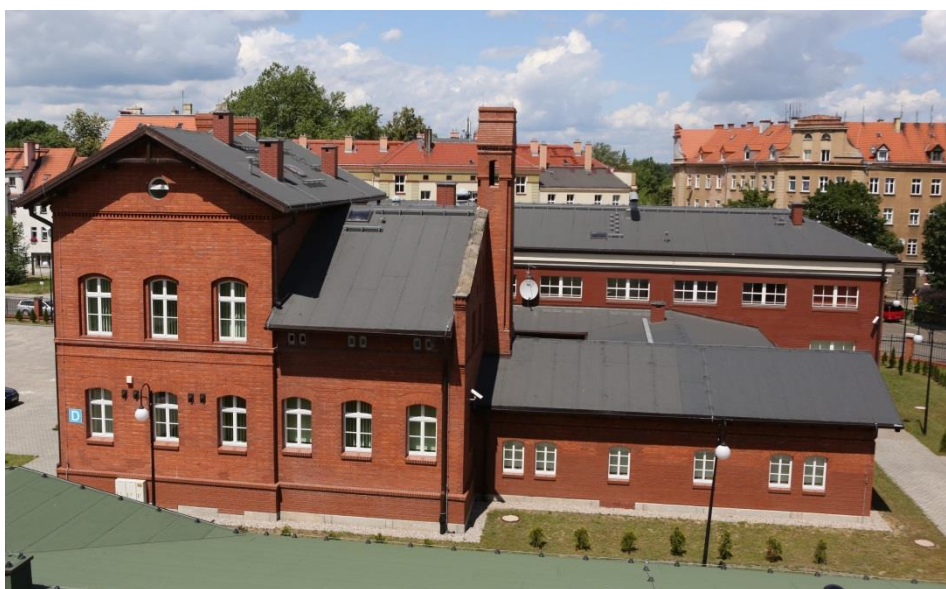
Rycina 9 Budynek D
