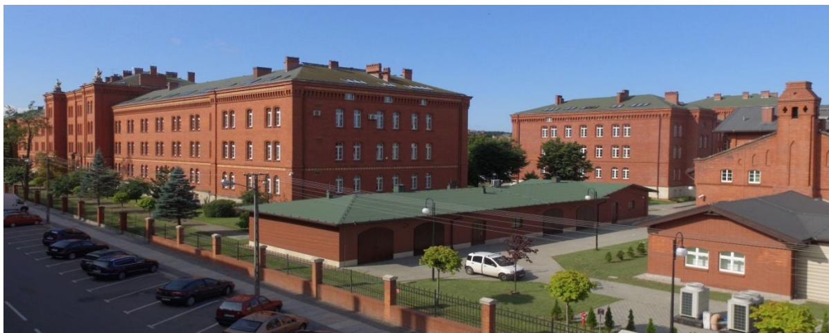
Rycina 7 Budynek A
